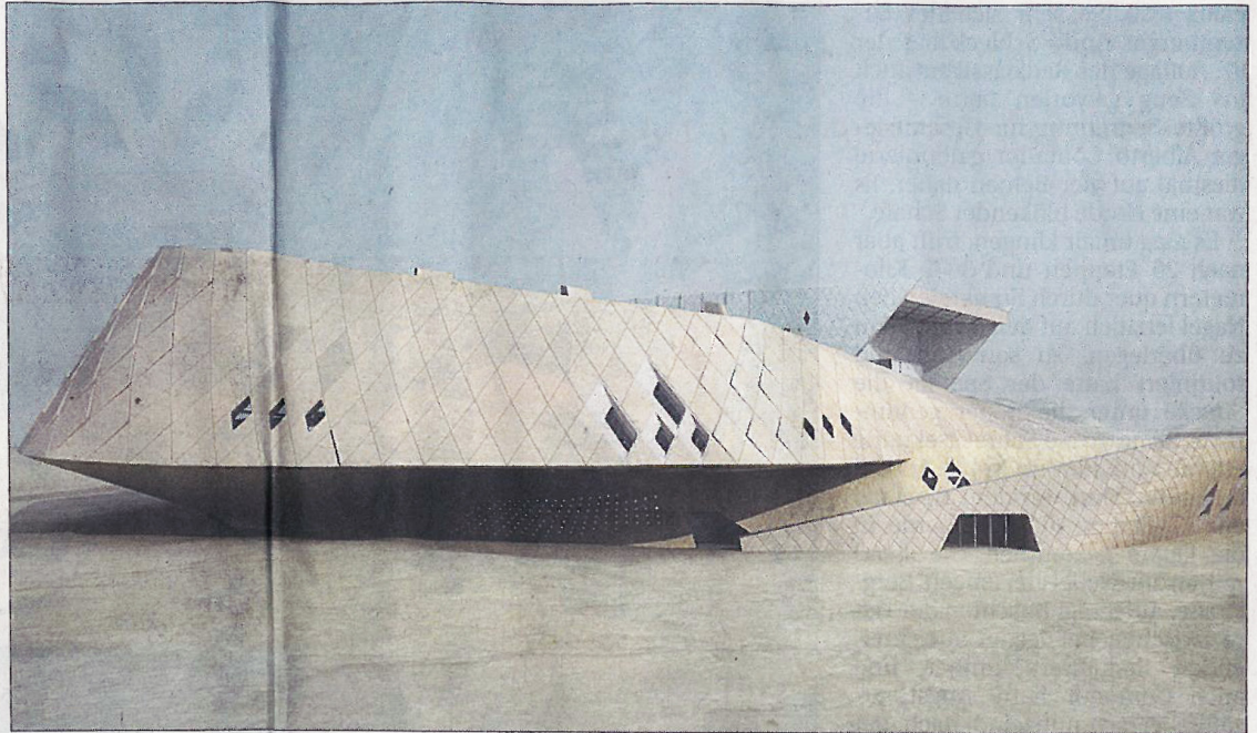
Steht nicht auf einem fremden Planeten, sondern bald als Besucherzentrum im Al Ain Wildlife Park der Vereinigten Arabischen Emirate. Wenige klug angeordnete Fenster und Bauteile mit integrierter Kühlttechnik sorgen dafür, dass die Gäste auch bei hohen Außentemperaturen einen angenehmen Aufenthalt haben.
